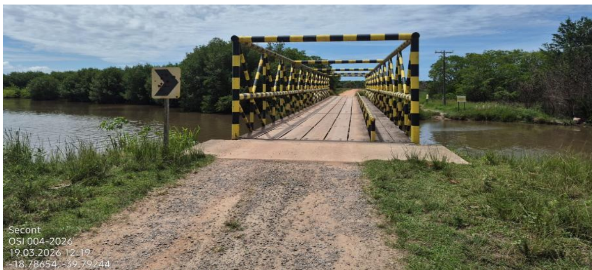
Figura 20: Ponte de serviço sob o rio Mariricú (fonte: Secont)
