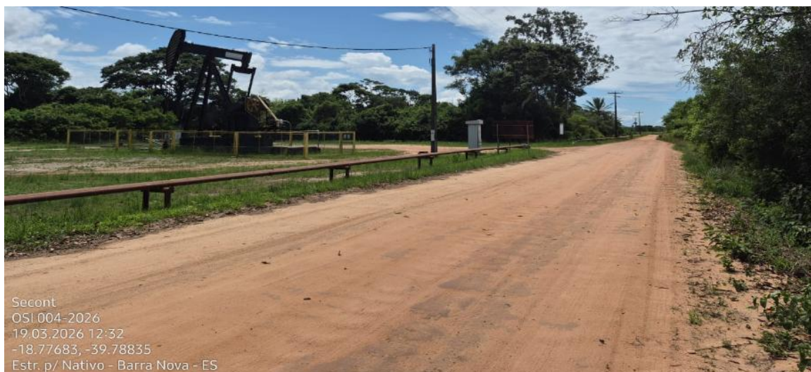
Figura 3: Presença de dutos aéreos verificada no local (fonte: Secont)
